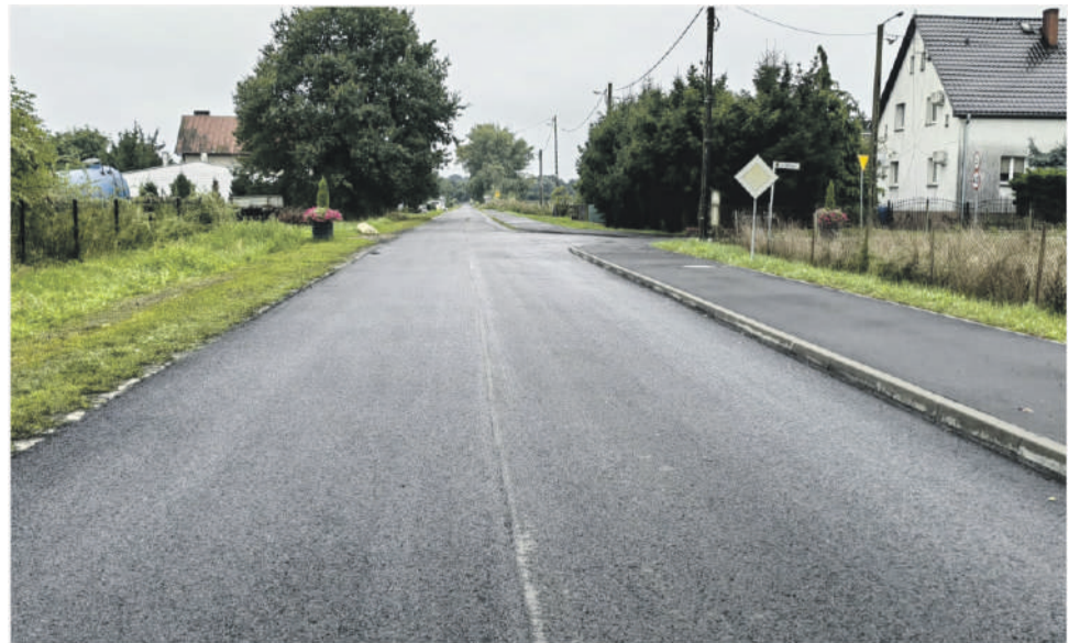
Nowa nawierzchnia drogi powiatowej w Kotowicach
