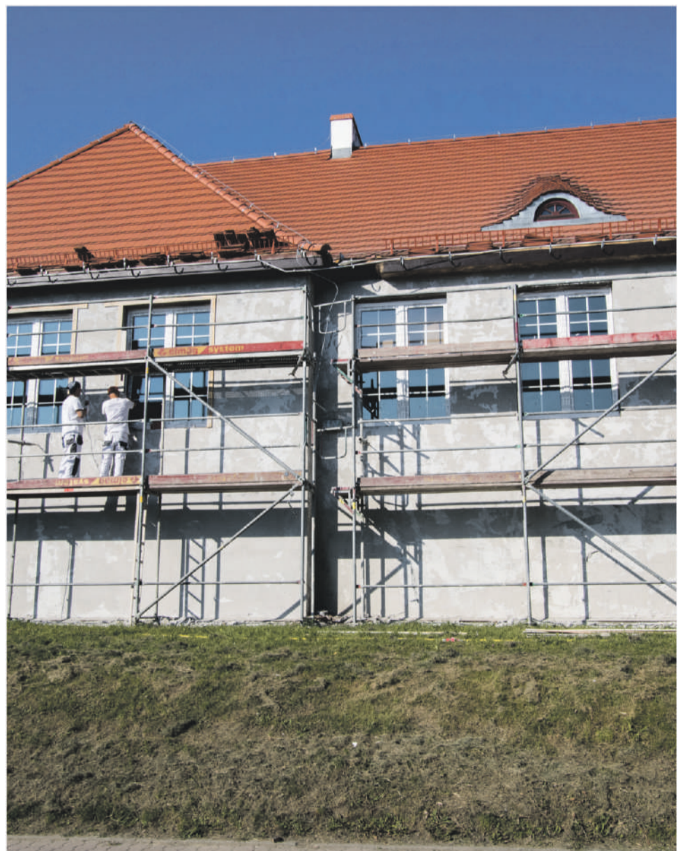
Budynek LO w Trzebnicy w trakcie termomodernizacji
