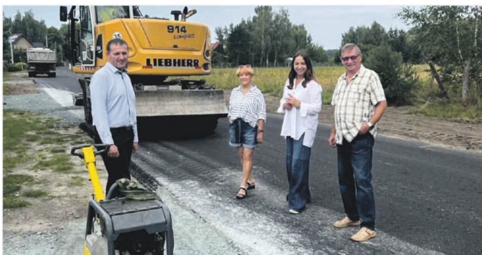
Nowa droga w Rudzie Żmigrodzkiej
