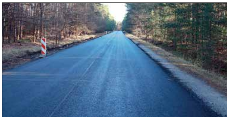
• Nowa nawierzchnia w znacznym stopniu poprawi bezpieczeństwo oraz komfort jazdy kierowców
