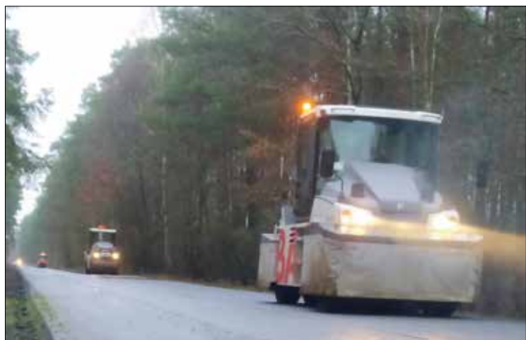
• Przebudowa drogi powiatowej nr 1400D (Gmina Trzebnica)
