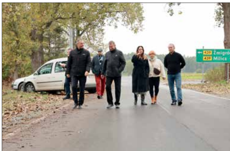
• Remont drogi w Rudzie Żmigrodzkiej (Gmina Żmigród)
