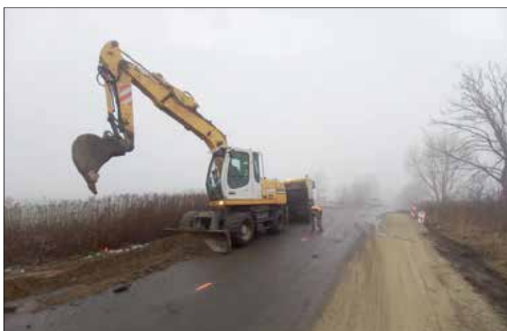
• Remont drogi powiatowej w Lubnowie (Gmina Oborniki Śląskie)
