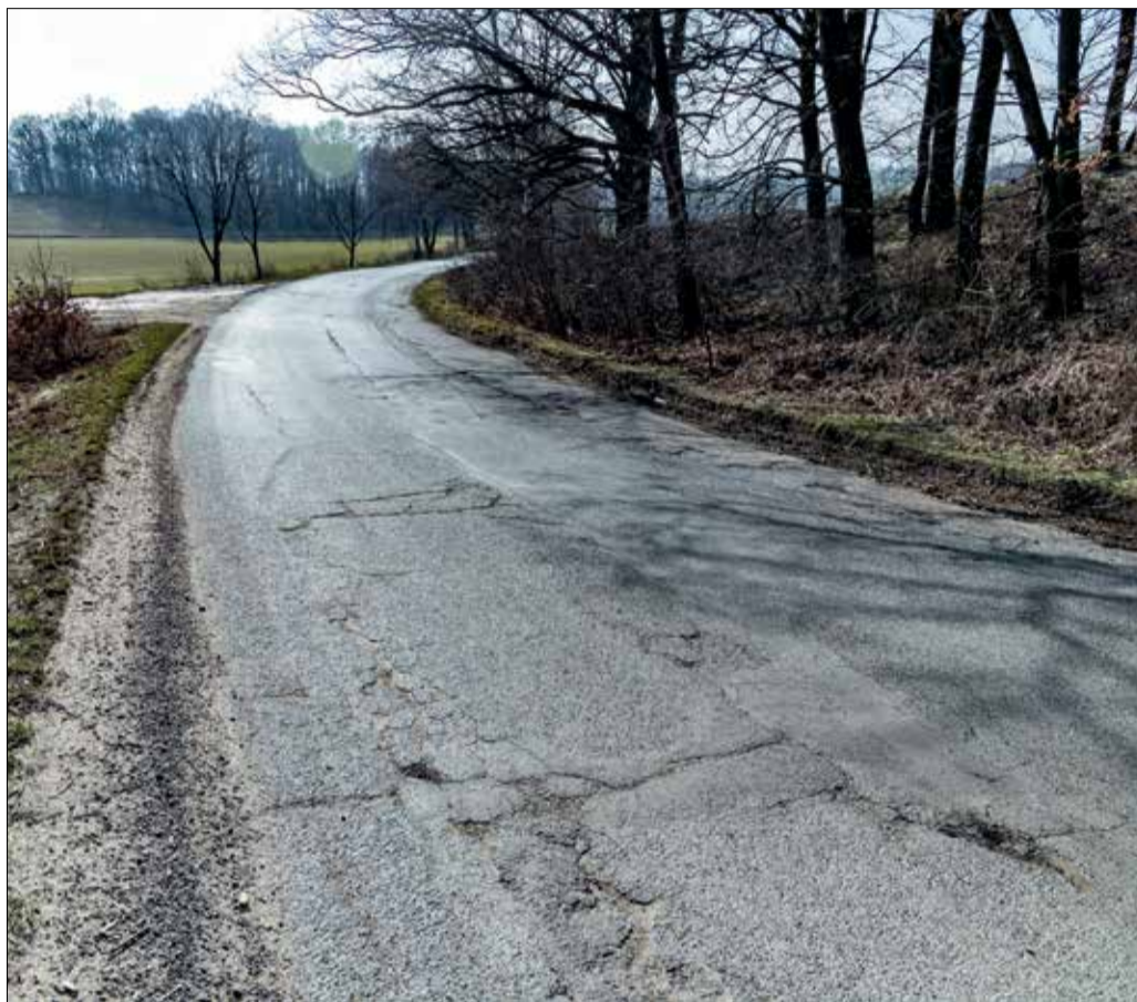
■ Wskazana droga pozwoli udrożnić ruch komunikacyjny na strategicznej drodze powiatowej, która łączy się z Powiatem Wrocławskim a następnie z drogą S8
