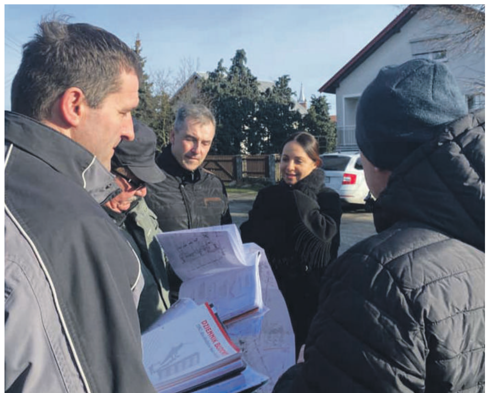
Przekazanie placu budowy w Korzeńsku
