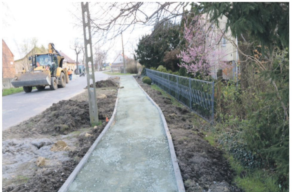
Budowa chodnika w Przedkowicach
