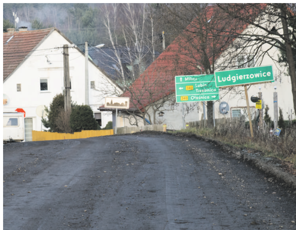
► Droga powiatowa Ludgierzowice – Rzędziszowice
