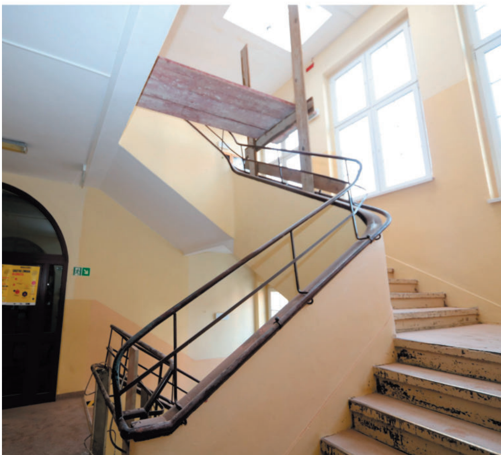
Platforma pionowa do transportu osób niepełnosprawnych zostanie wybudowana do końca lipca 2021 roku
