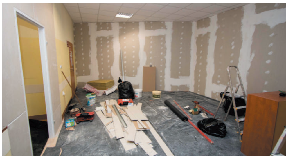
Uruchomienie szpitalnego punktu szczepień wymagało dostosowania pomieszczeń i przeprowadzenia remontu
