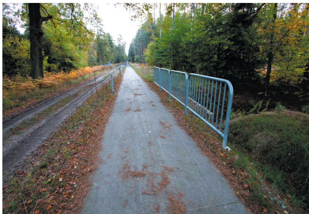
Zrealizowany odcinek ścieżki rowerowej na odcinku Książęca Wieś - Gruszcza
