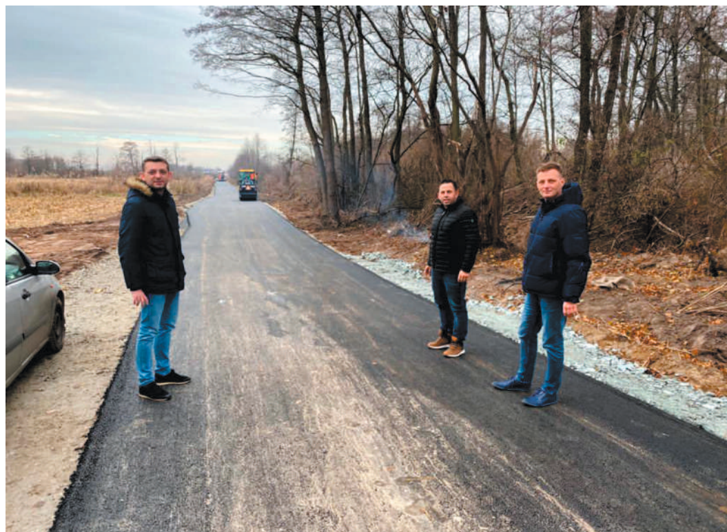
Nowy odcinek rowerostrady prusickiej o długości 1,3 km łączący Gminę Prusice z Gminą Trzebnica od Pawłowa Trzebnickiego do Brzykowa
