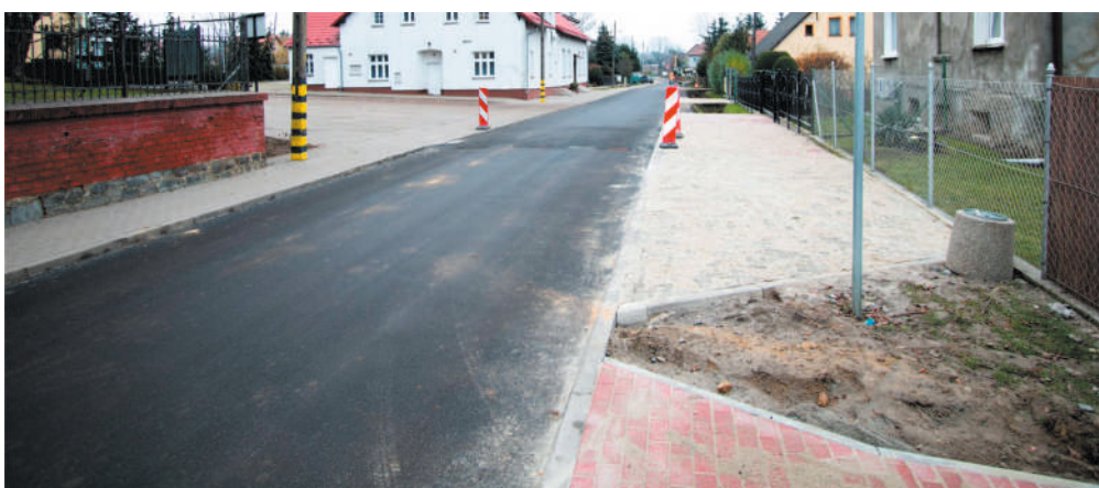
Przebudowa drogi w miejscowości Piotrkowiczki to kolejna inwestycja zwiększająca bezpieczeństwo mieszkańców
