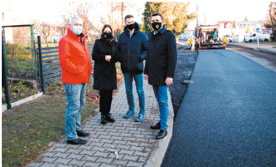
O remont drogi zabiegał Radny Rady Powiatu Trzebnickiego Jan Zdziarski
