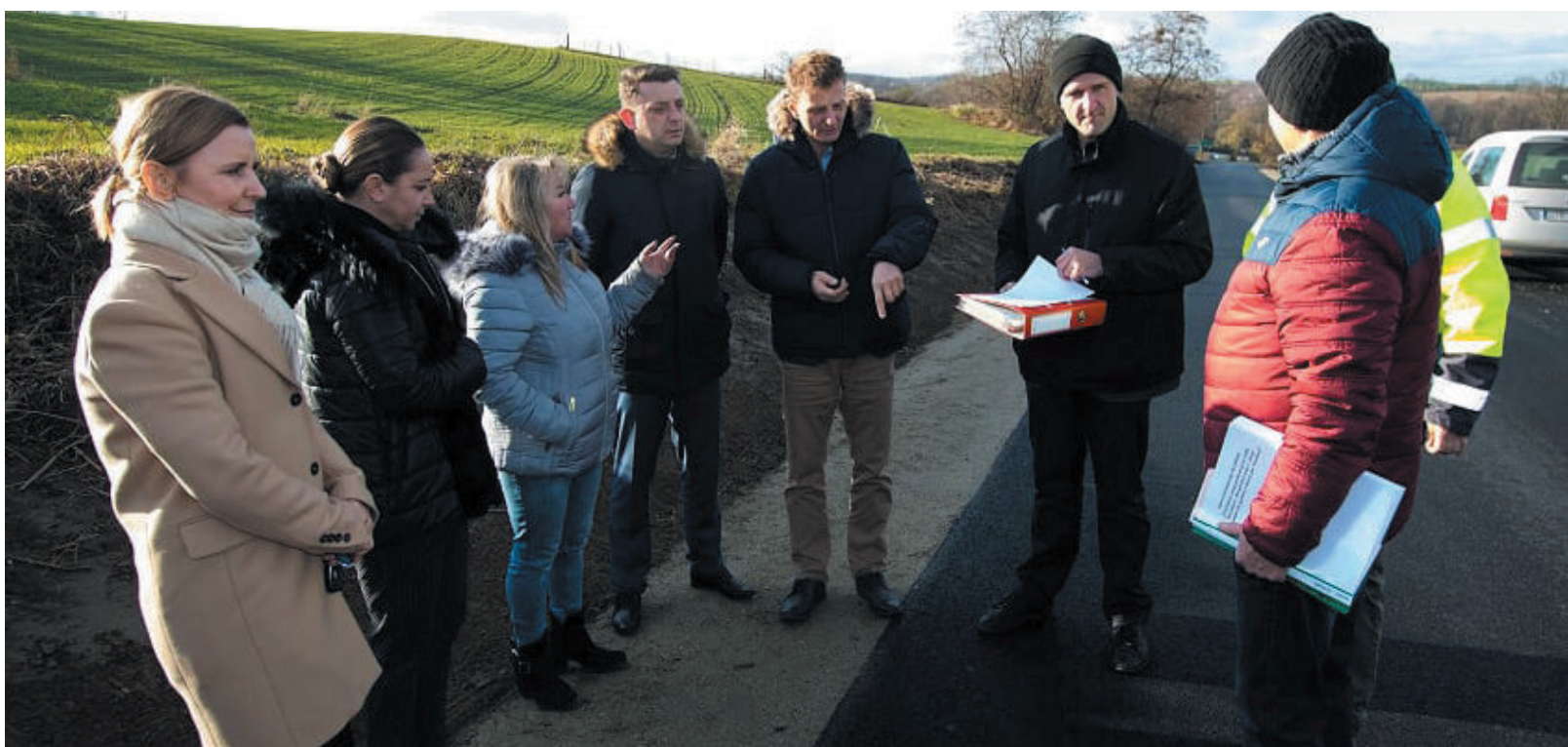
Nowa nawierzchnia drogi Marcinowo - Rzepotowice
