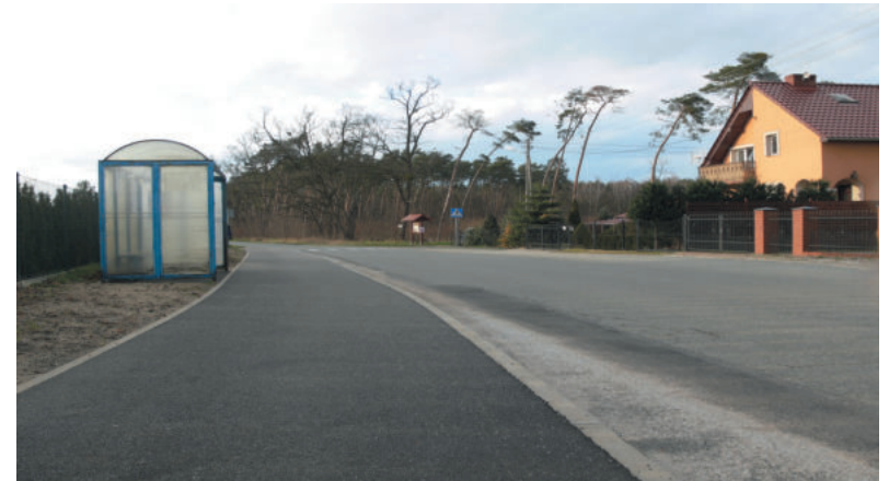
Chodnik przy drodze powiatowej w miejscowości Kałowice, Gmina Zawonia
