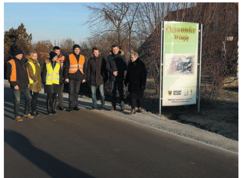
Przebudowa drogi powiatowej w Ozorowicach, Gmina Wisznia Mała
