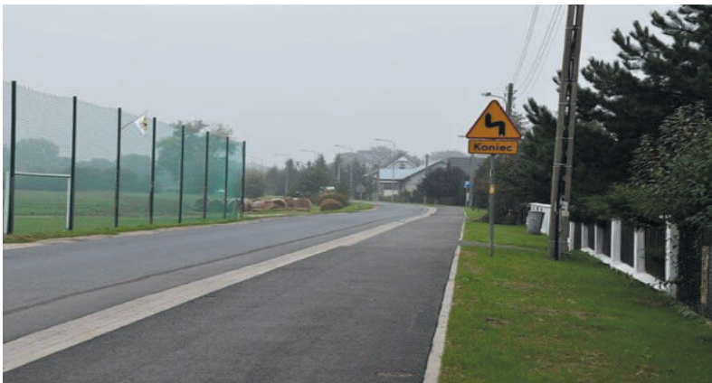
Chodnik przy drodze powiatowej nr 1362 D Kotowice - Paniowice, Gmina Oborniki Śląskie
