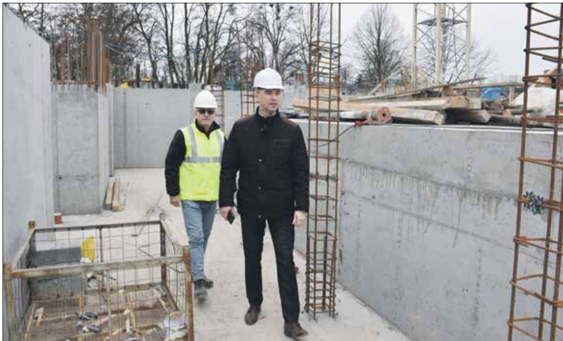
• Burmistrz Żmigrodu Robert Lewandowski w trakcie wizyty na placu budowy Delfinka
