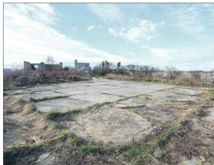
• Obecny stan lądowiska na Nowym Dworze
