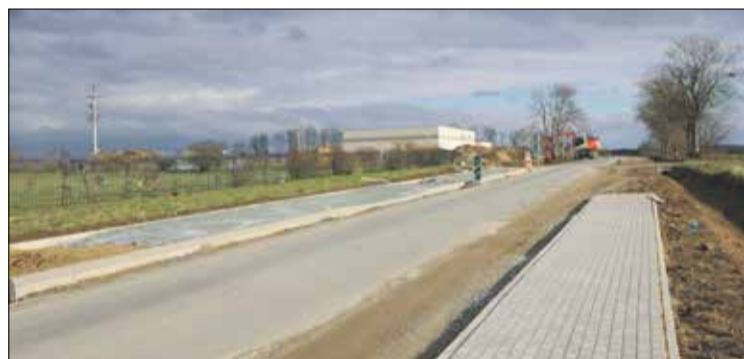
■ Już niedługo mieszkańcy Szewc będą mogli korzystać z nowego chodnika
