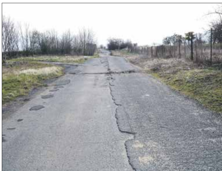
• Droga dojazdowa do lądowiska dla LPR na Nowym Dworze
